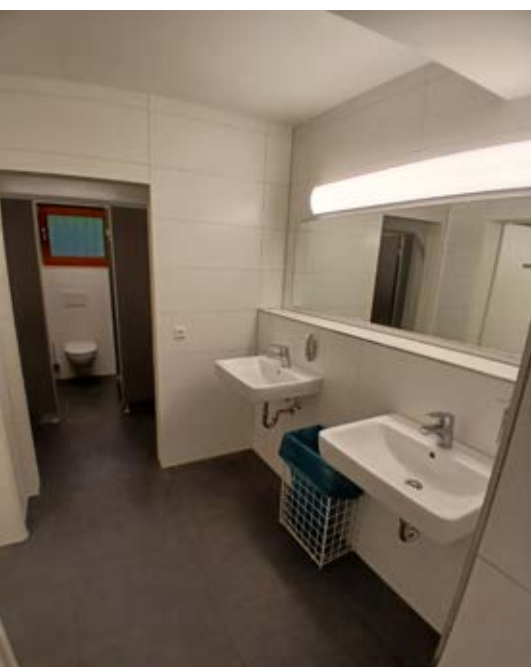
Neue Waschbecken und eine moderne Beleuchtung erzeugen ein völlig neues Raumgefühl.
