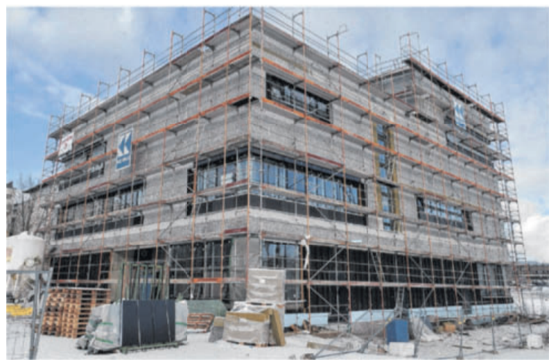
Die Baustelle am Sportquadrat in Bietigheim-Bissingen in der Schwarzwaldstraße 31 Mitte Januar.
